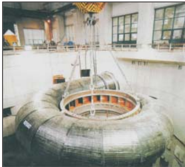
Slika 3: Spirala turbine (prije ugradnje)
